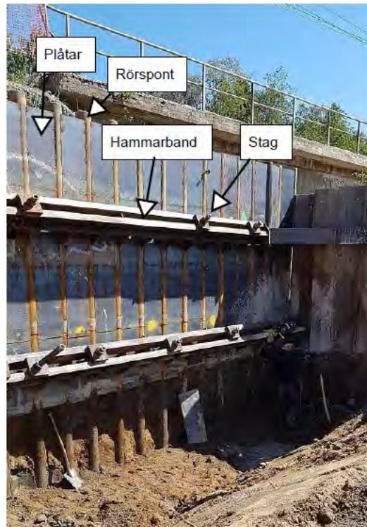
Figur 2.1: Beskrivning av spontens olika delar
