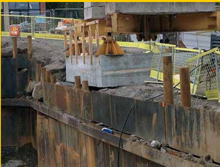
Stora mark-sättningar under kranfundamentet på grund av kraftigt utbuktande spont, vilket ses på det icke-kontinuerliga hammarbandet.
